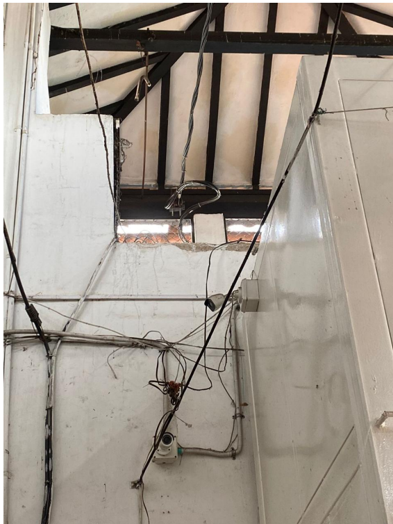
Figura 1.2: Red principal en baja tensión que recorre el área de la plaza (alimentación general).
