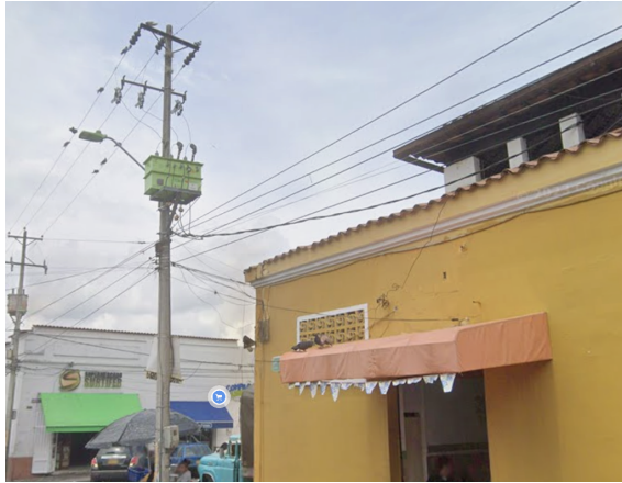
Figura 1.1: Transformador principal de la Plaza de Mercado "La Concordia" (punto de alimentación en baja tensión).
